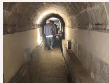
Tunnel im Wasserreservoir
